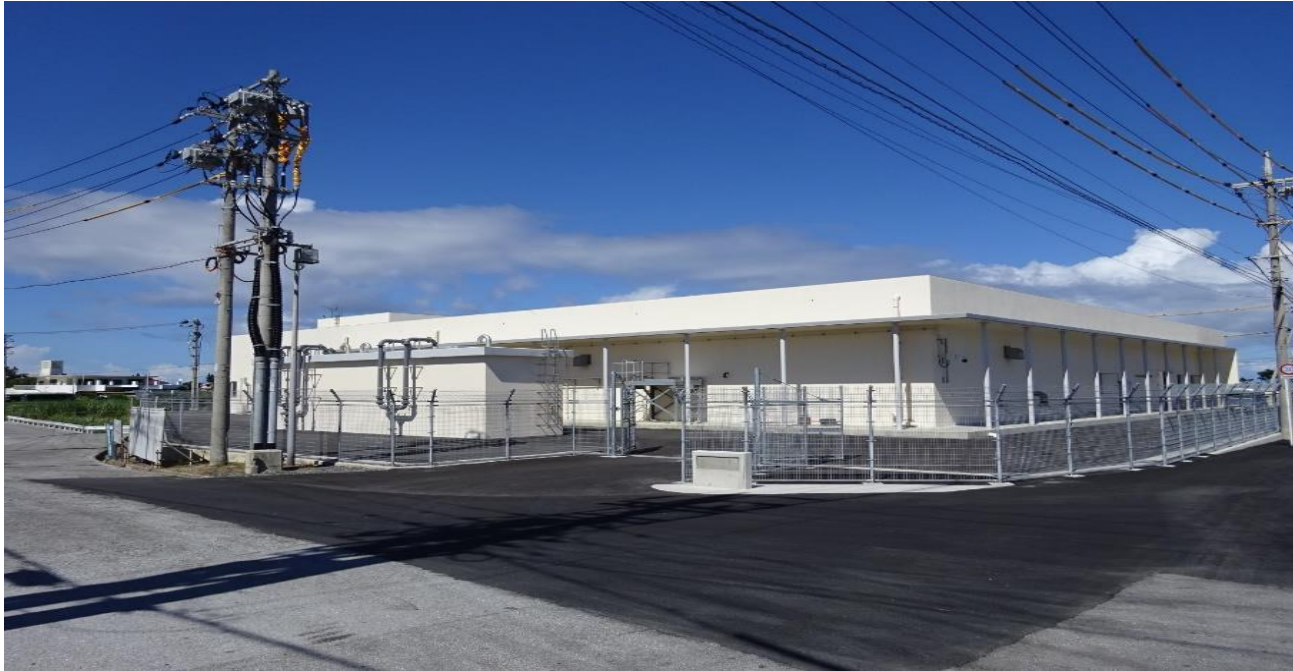
伊是名浄水場
