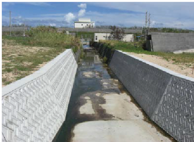
排水路の改修(断面拡大)
