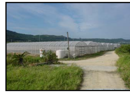
ビニルハウスの設置
