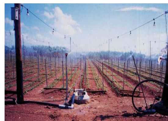
写真⑤ 施設（給水栓）の状況
