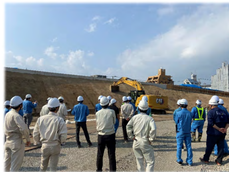
ICT施工(法面工)現場見学会
