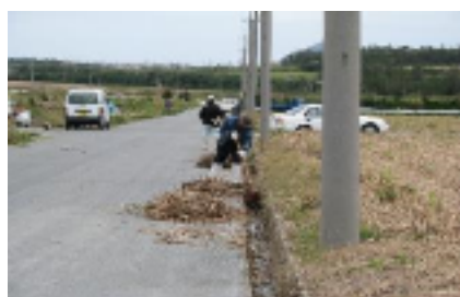
排水路の泥上げ
