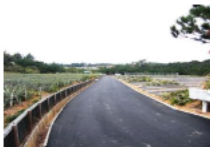
グリーン・ベルト しがら工 (排水路への耕土の流出を抑制)
