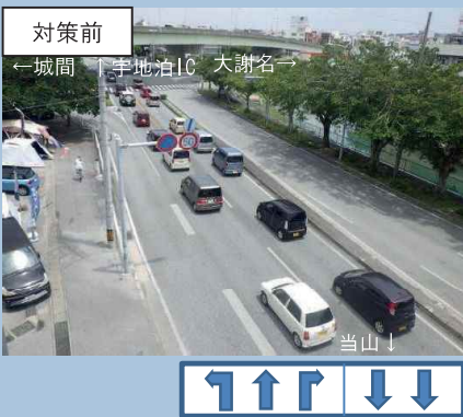
【対策前】県道153号線バイパスから国道58号へ、直進(宇地泊IC)及び右折(大謝名)が渋滞
