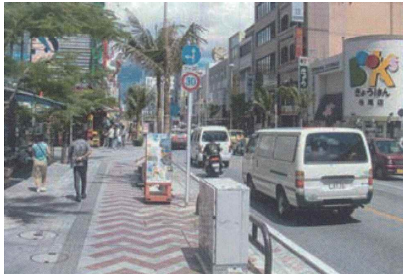
県道39号線国際通り(那覇市久茂地) 無電柱化推進事業
