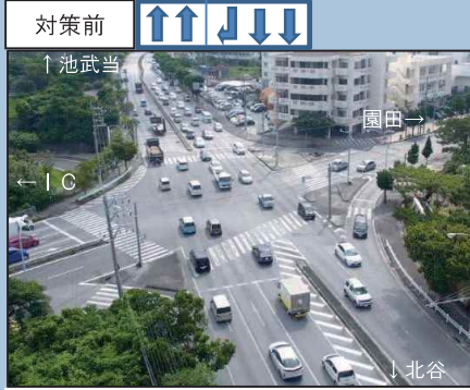
【対策前】池武当方面からICへの右折車線が1車線であったため、渋滞が慢性化
