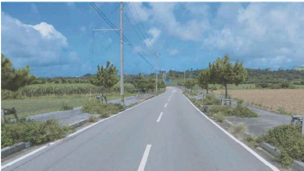
(写真箇所：城辺長間～下里添区間)
