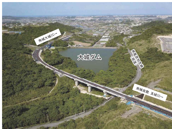
大城ダム付近
