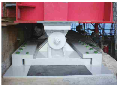
改造後の支承
