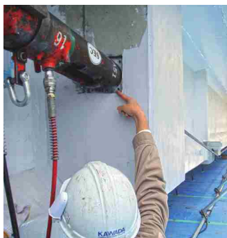
主桁外ケーブル緊張
