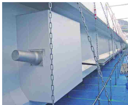
主桁外ケーブル設置完了
