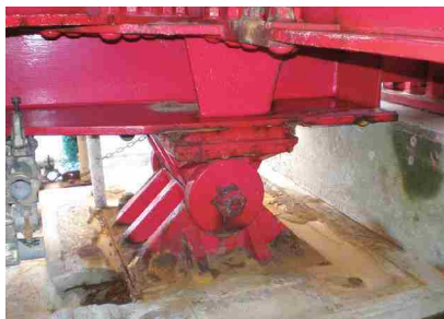
改造前の支承
