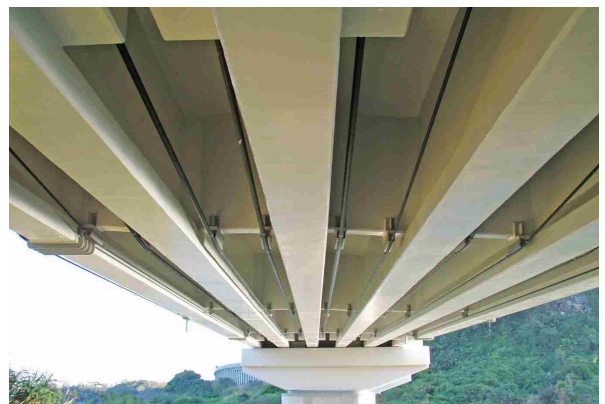
主桁外ケーブル(支間中央部)
