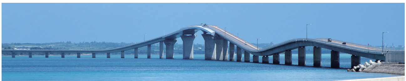
伊良部島側から見た伊良部大橋
