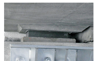
支承ゴム取替え完了
