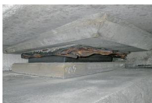
支承ゴム取替え前
