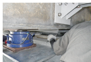
支承ゴム撤去・設置
