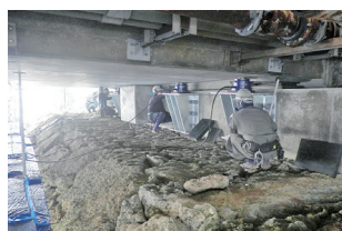
ジャッキ取付け
