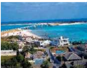
のほ 野甫大橋 ⑱
