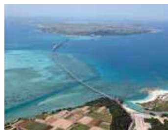
いらぶ 伊良部大橋 ㉑
