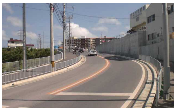
国道507号(八重瀬町伊覇) 公共交通安全事業
