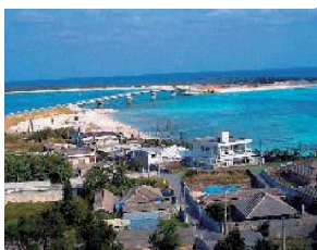
のほ 野南大橋 ⑱
