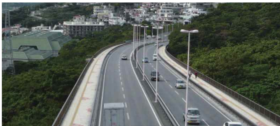
真地久茂地線（真地大橋）
