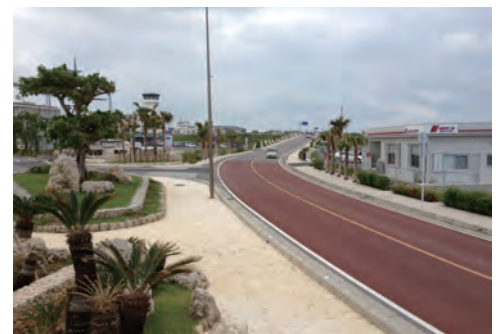
○定住を支援する道路整備（新川白保線）
