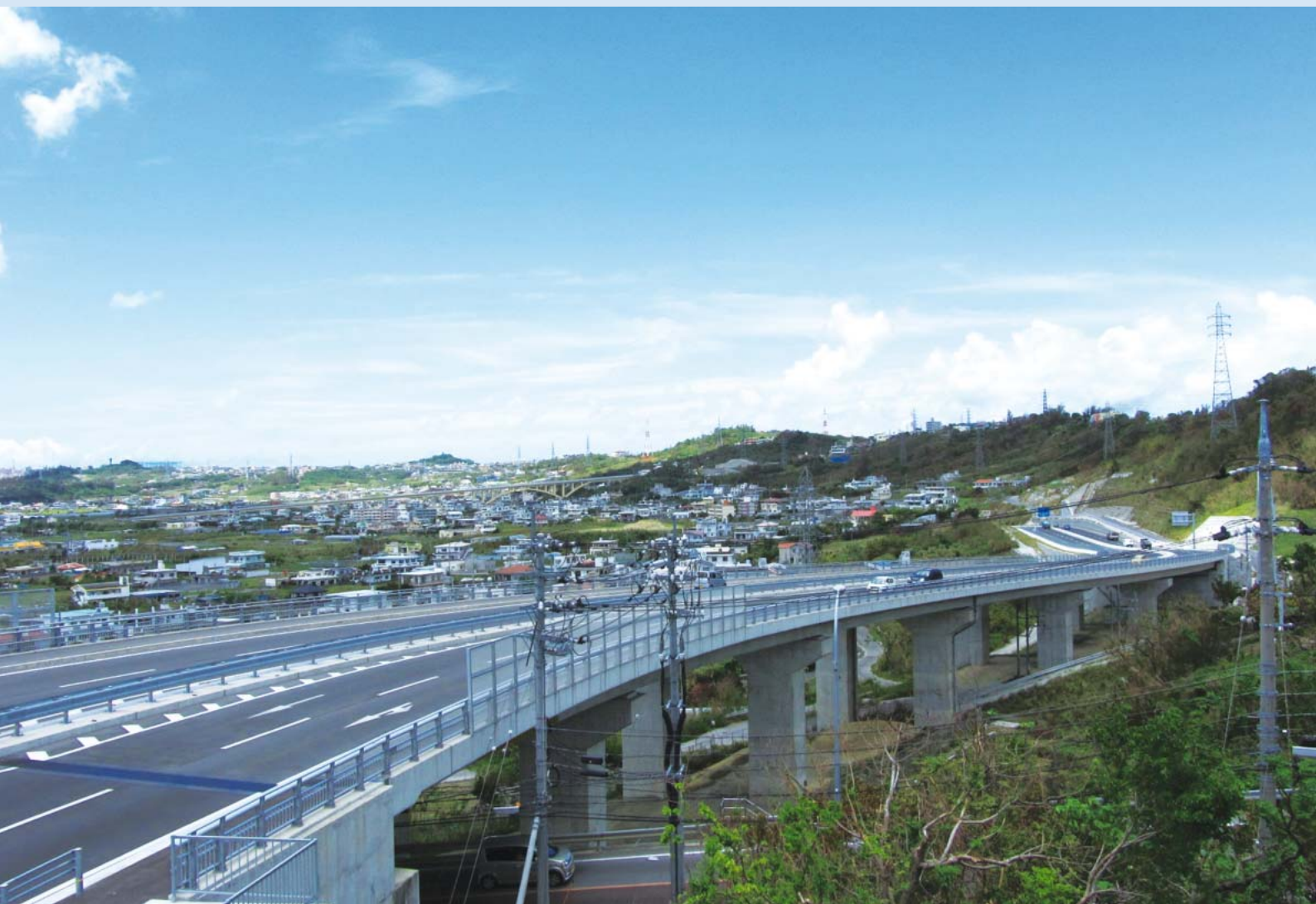
一般県道 具志川沖縄線(川田大橋)
