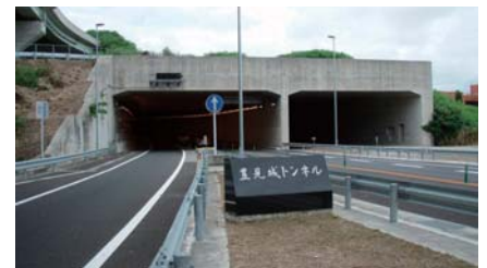
豊見城トンネル
