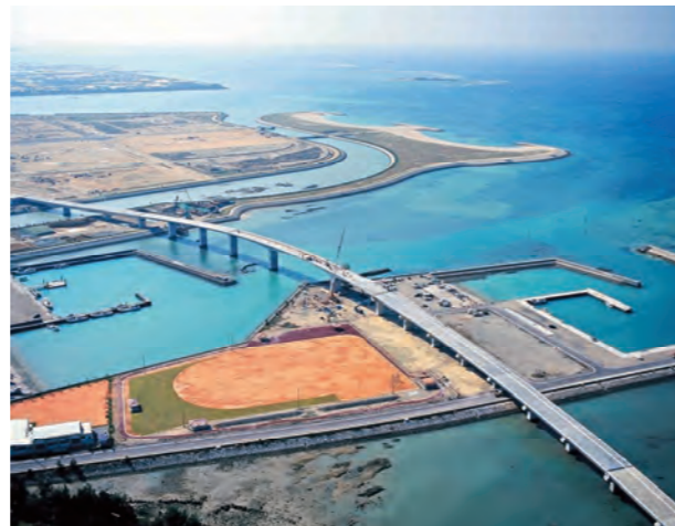
国道331号豊見城道路
