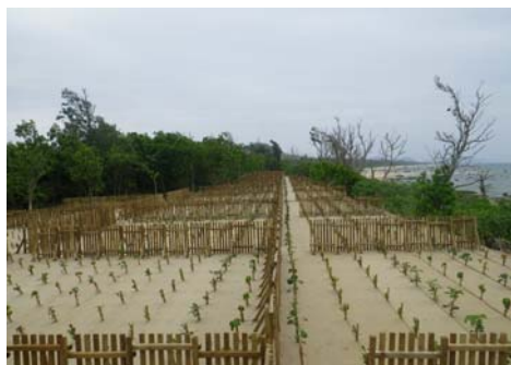
木製パネル防風工
