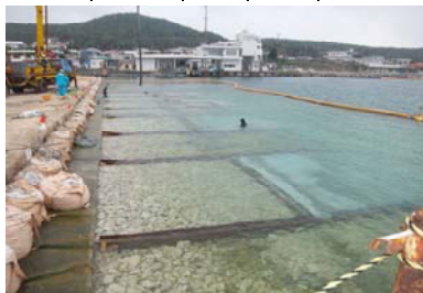
漁港工事 施工状況
