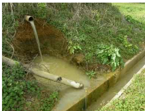
地点⑧ 水田状況(濁水流出)
