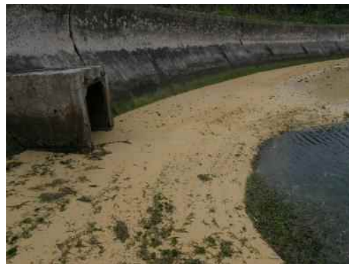
地点① 河口域カルバート(水流無し)
