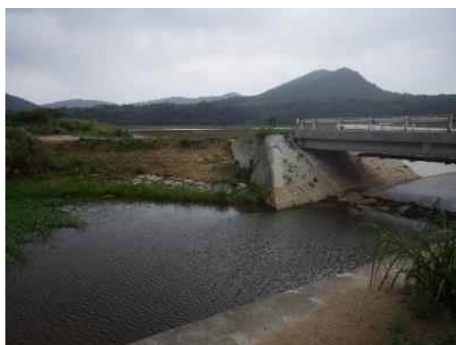
地点⑨ 工事完了状況(濁り無し)
