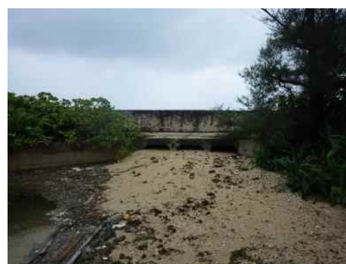
地点⑥ 水路から海域側(閉塞)
