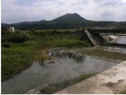
地点⑨ 工事完了状況(濁り無し)
