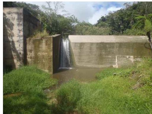
地点⑫ 地点⑩の更に上部にある砂防ダム
