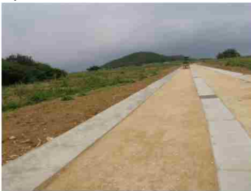
地点⑦ 沈砂地に繋がる造成中農道
