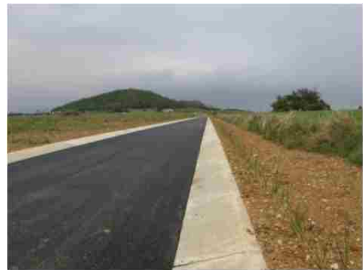
地点⑧ 造成中農道(グリーンベルト有り)
