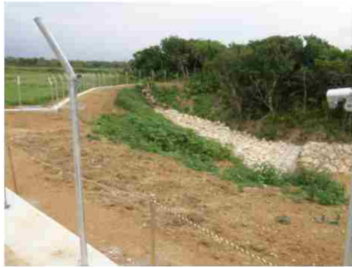
地点⑥ 造成中の沈砂地
