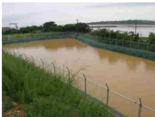
地点⑨ 沈砂池(濁り多)
