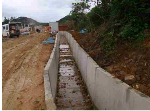
地点⑨ 造成地横水路の整備
