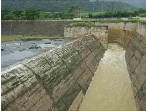
地点⑤ 真栄里ダムからの放水(濁り多)
