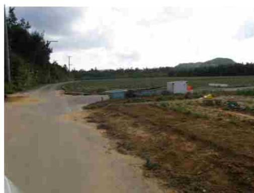
地点⑪ 道路への流出痕
