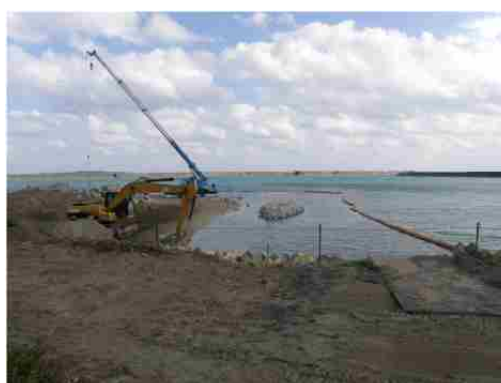
地点② 汚濁防止膜の設置
