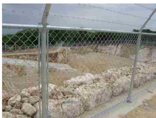
地点④ 造成中の沈砂地
