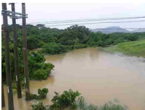
地点② 赤下橋箇所(水位が上昇し越流)
