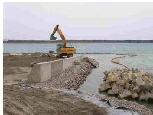
地点① 工事現場(防止膜有り)
