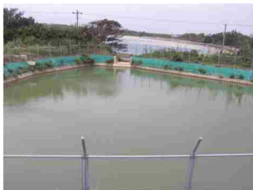
地点② 既存の沈砂地
