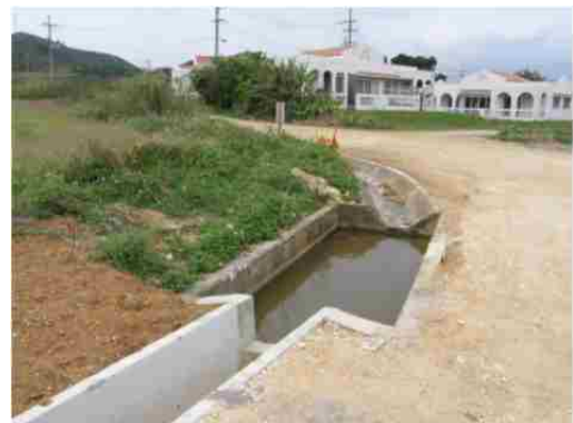
地点⑩ 造成中水路(流出可能性有り)
