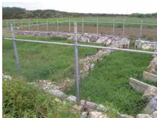
地点③ 既存の沈砂地
