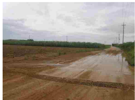
地点⑭ 畑からの土砂が道路に流出
