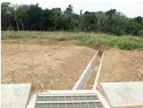
地点⑨ 造成中水路(流出可能性有り)
