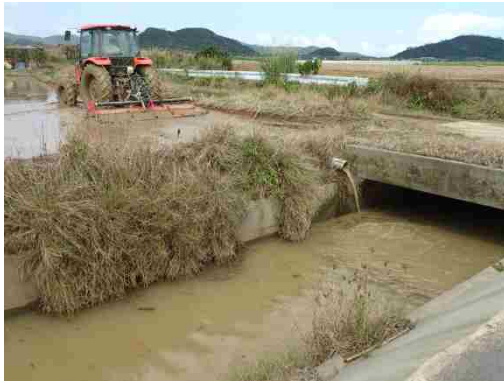
地点⑦ 水田から濁水が流出
