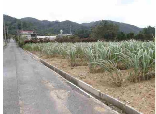
地点⑦ 流出可能性がある箇所
