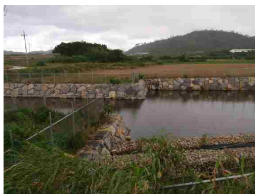
地点⑱ 整備途中の沈砂地
