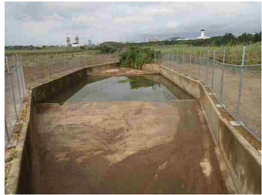
地点⑬ 沈砂池
