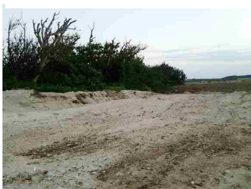
地点⑰ 末端に盛土による対策
