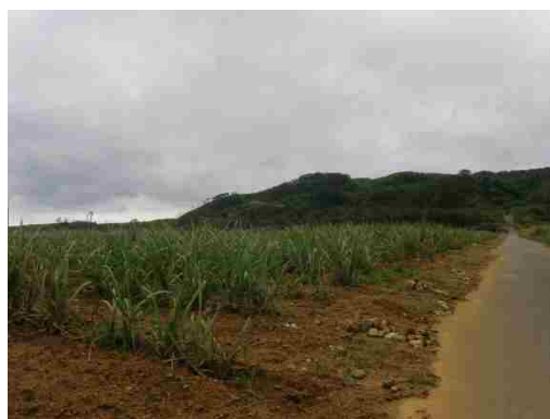
地点④ 畑からの流出痕
