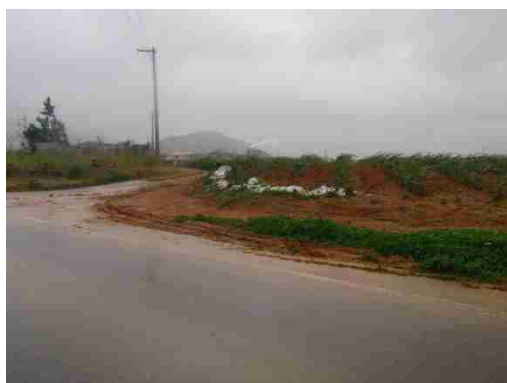
地点⑫ 流出源となりうる箇所
