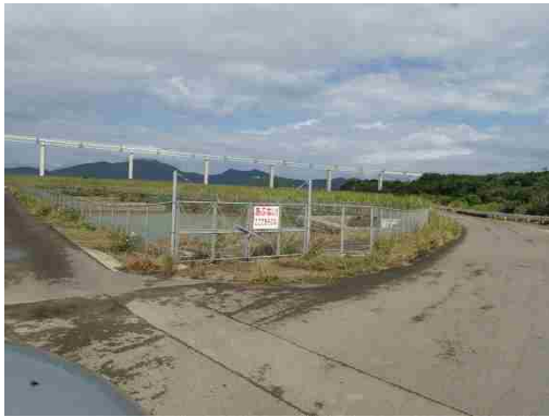
地点⑫ 沈砂池
