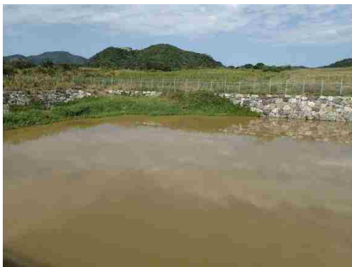
地点⑭ 濁水流出源の沈砂池
