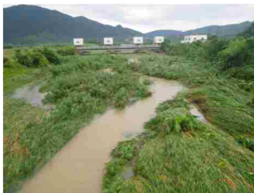
地点⑤ 名蔵頭首工が開き下流が浸水
