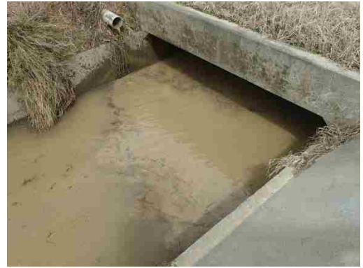
地点⑦ 水田から濁水が流出
