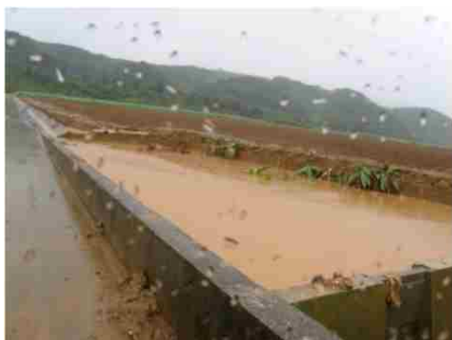
地点④ 集水桝の状況
