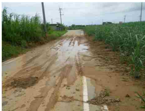
地点⑨ 道路への流出痕
