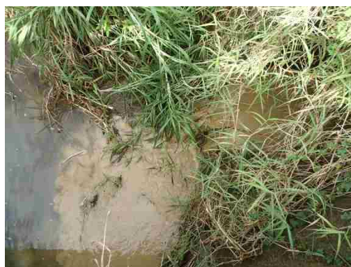
地点⑤ 水田から濁水が流出
