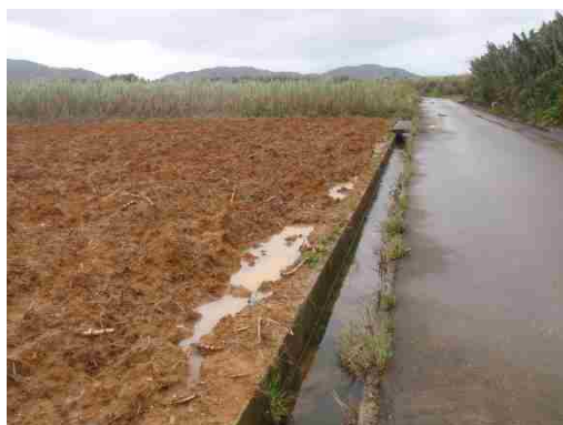
地点⑩ 流出源となりうる箇所
