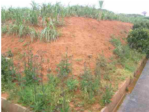
地点⑧ 流出可能性がある箇所
