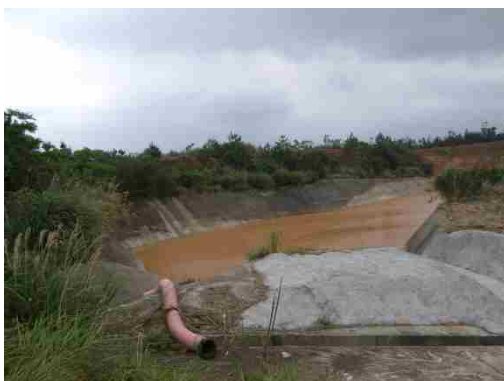
地点⑫ ダム下流周辺整備工事による沈砂池
