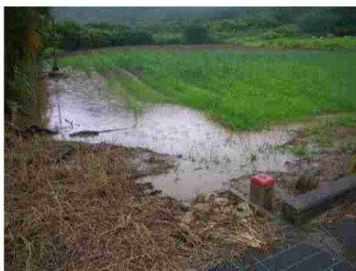
地点⑤ 浸水し濁水が側溝に
