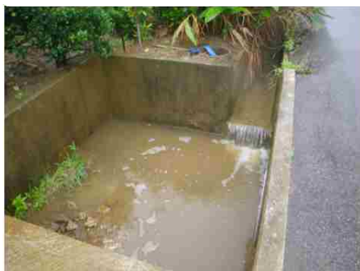
地点⑧ 排水路と集水桝(濁り有り)
