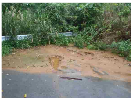
地点⑤ 土砂が道路に流出
