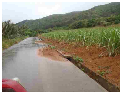
地点④ 土砂が道路に流出
