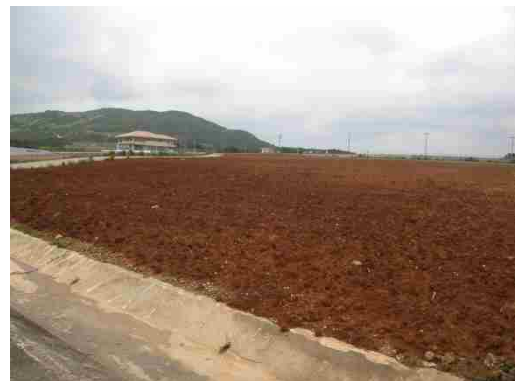
地点⑪ ダム下流周辺整備工事による裸地
