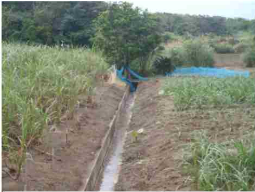
地点⑤ 流出可能性有り
