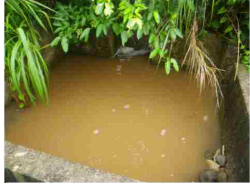
地点⑤ 集水桝(濁り有り)
