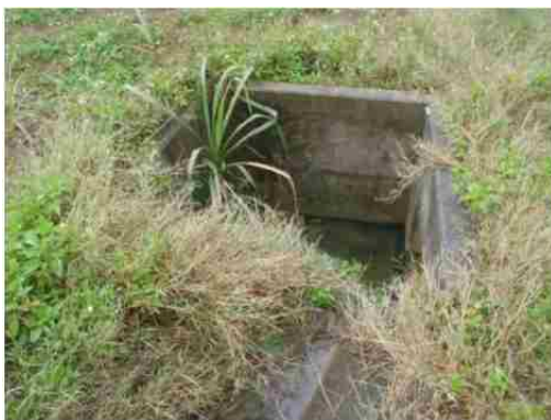
地点⑧ 水路末端の溜め柵
