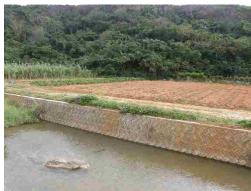
地点④ 河川(流出痕有り)
