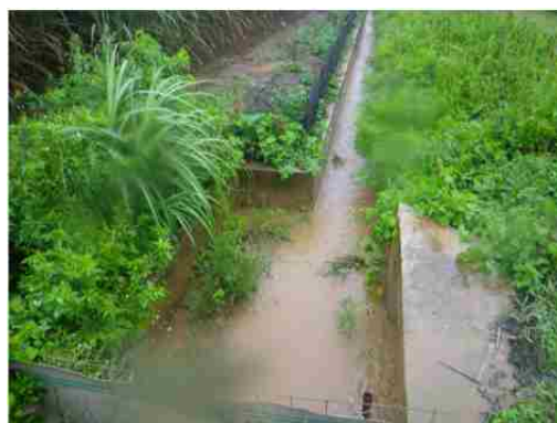
地点⑦ 排水路と集水桝(濁り有り)
