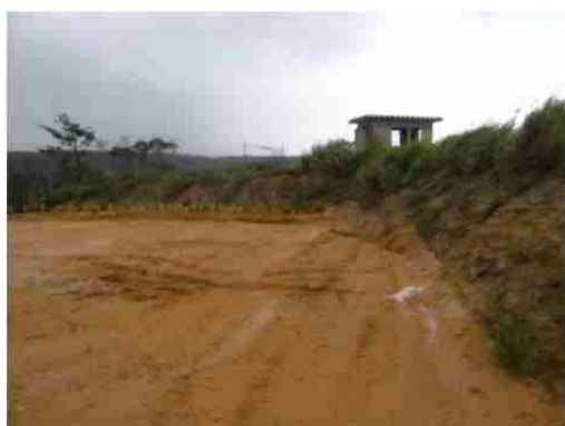
地点⑨ 裸地際にグリーンベルト(ベチバー)
