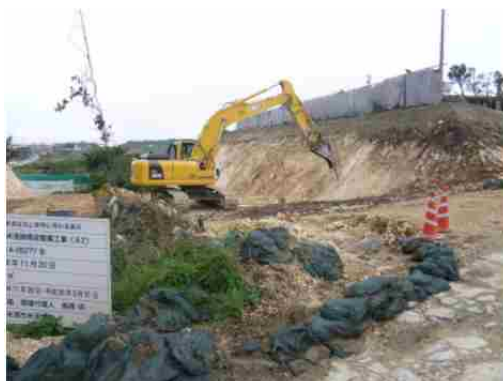
地点④ 土嚢による流出防止対策
