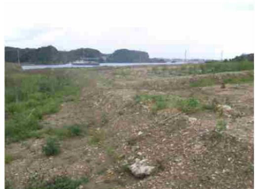
地点③ 造成地内、盛土による対策
