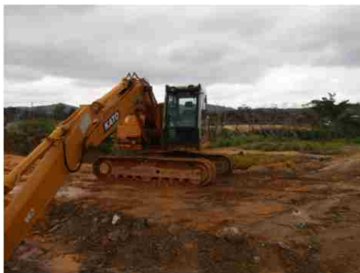
地点⑧ 重機による造成
