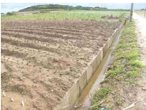
地点⑭ 流出可能性が有る箇所
