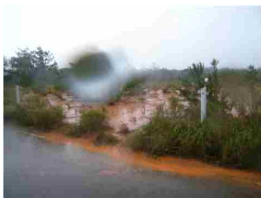
地点⑧ 裸地からの濁水が道路に流出
