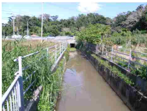
地点④ 支流部(濁り多)
