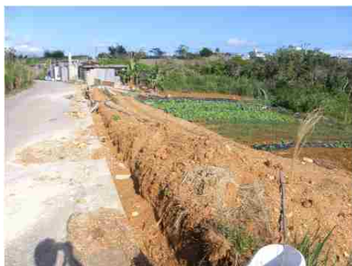
地点⑦ 排水路工事に伴う裸地
