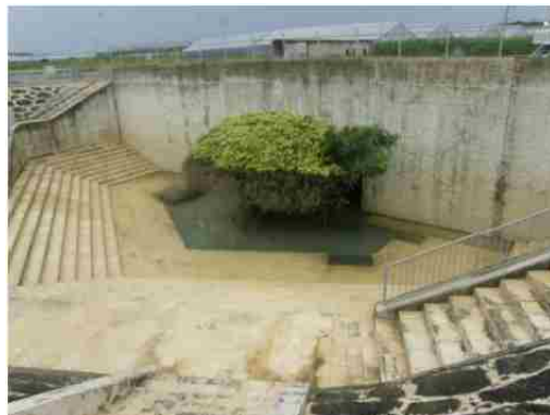
地点② 地下ダム施設(増水・濁り無し)
