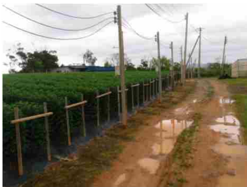
地点⑨ 前回確認流出箇所
