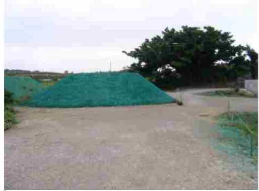
地点④ 吹き付け工による対策
