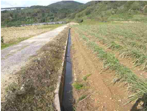
地点⑩ 流出可能性が有る箇所
