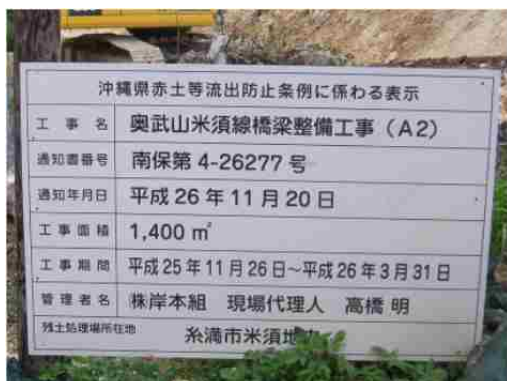
地点④ 橋梁整備工事看板
