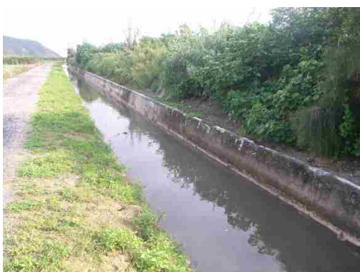
地点③ 河川状況(濁りあり)
