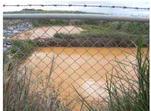
地点⑨ 沈砂池状況(濁り有り)
