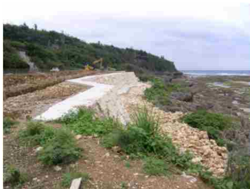
地点③ 工事現場の海岸の状況
