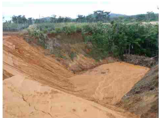
地点⑧ 裸地内土砂崩れ箇所
