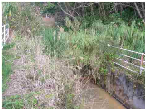
地点⑤ 堰(越流無し)
