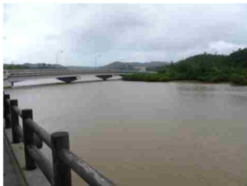
地点① 河口域(濁り有り)
