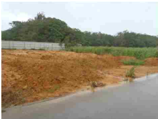
地点⑤ 流出可能性がある箇所
