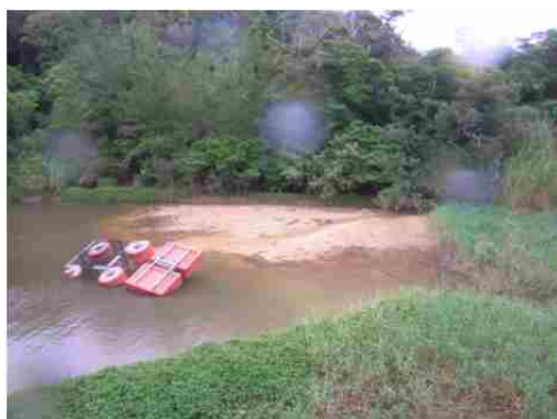
地点④ 砂防ダム直上の土砂堆積
