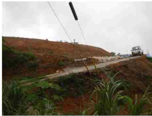
地点⑨ 流出可能性がある箇所
