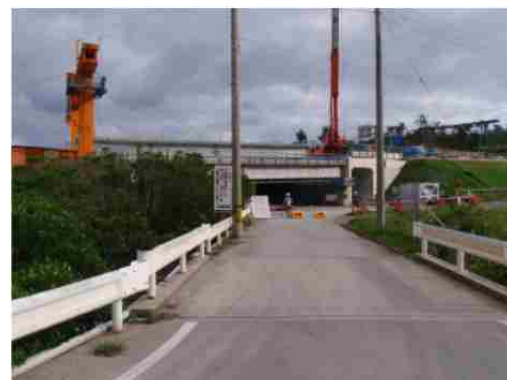
地点⑤ 橋梁工事遠景
