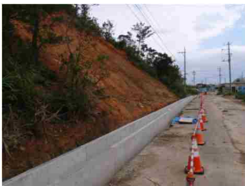
地点③ 土砂崩れ箇所前面の敷設工事
