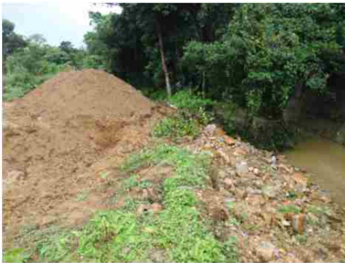
地点⑧ 河川際の盛土状況
