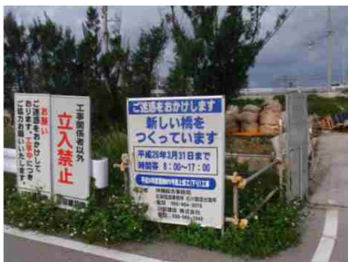
地点④ 橋梁工事看板
