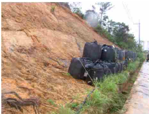
地点⑨ 土砂崩れ箇所対策の改善
