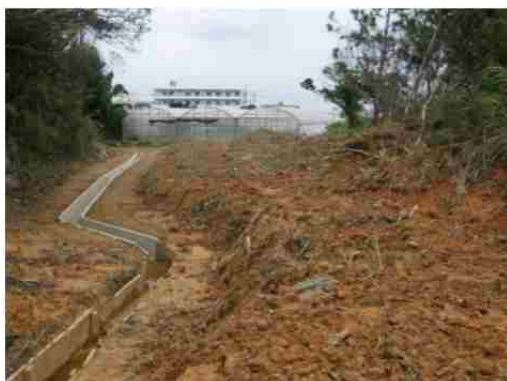
地点③ 新規造成水路と周辺裸地
