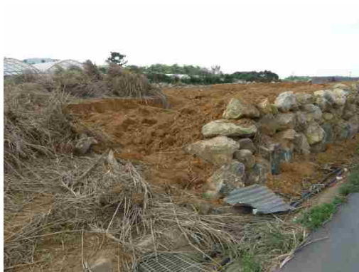
地点⑦ 新規確認造成地
