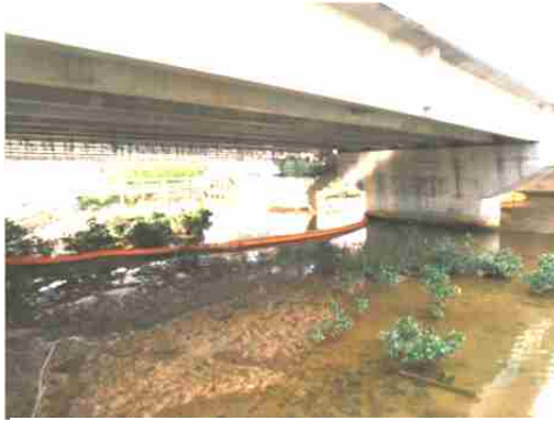
地点⑥ 汚濁防止膜設置
