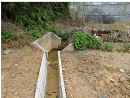
地点③ 既存水路との接続
