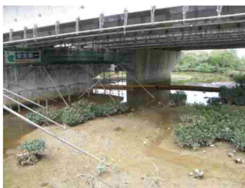
地点② 汚濁防止膜
