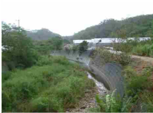
地点④ 上流域(濁り無し)
