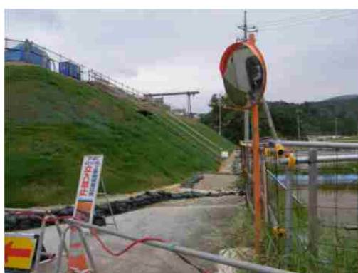
地点② 法面緑化工と沈砂地
