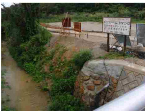
地点⑤ 前回確認法面状況
