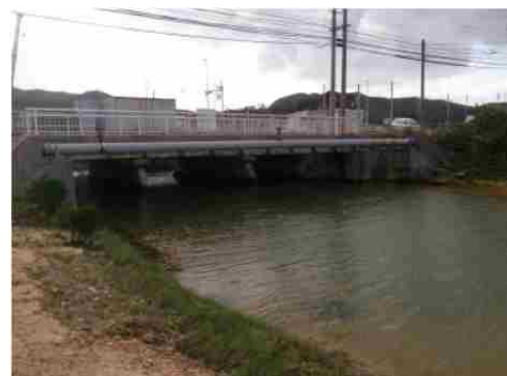
地点①植栽工事端横に河口
