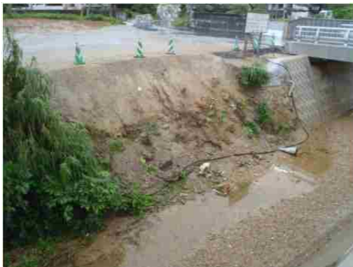
地点③ 昨年度確認工事箇所状況
