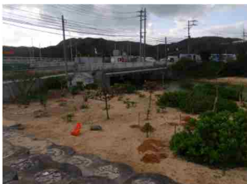
地点③ 河口部での植栽工事
