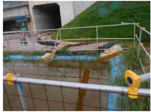
地点⑦ 沈砂地
