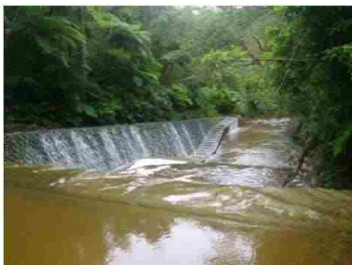
地点⑤ 砂防ダム
