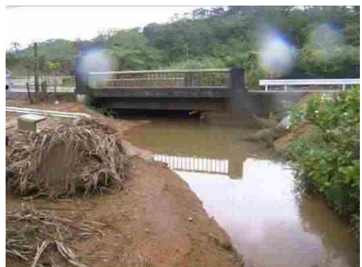
地点⑤ 周辺河川状況
