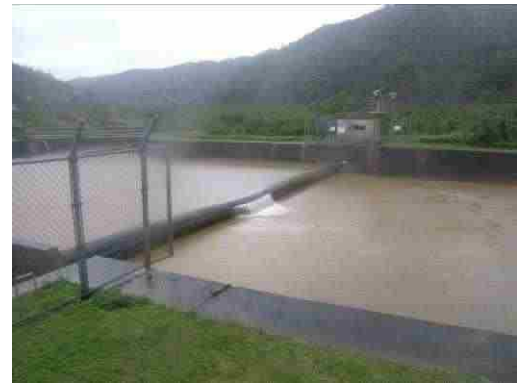
地点①直上 ラバー堰越流状況
