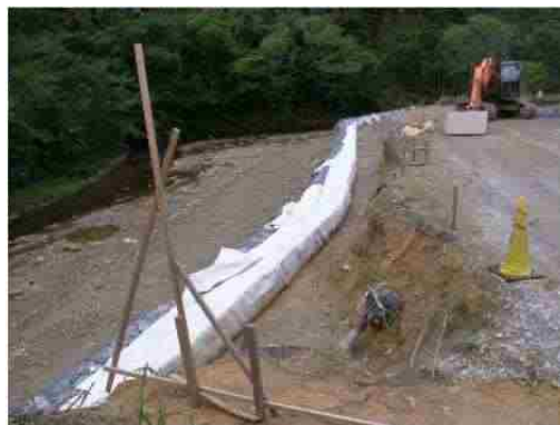
地点⑧ 河川護岸工事
