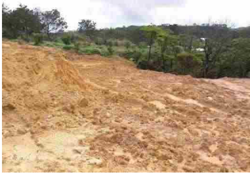
地点④ 造成裸地状況
