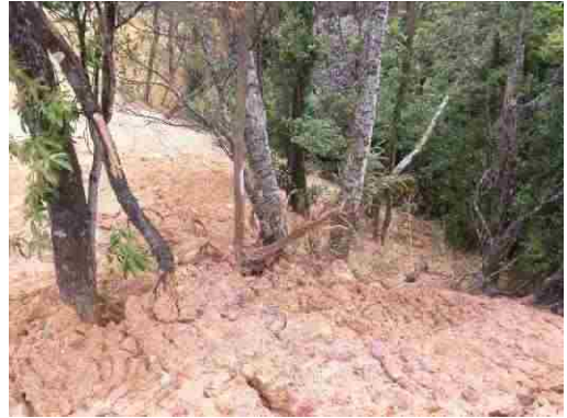
地点④ 土砂が斜面に流出
