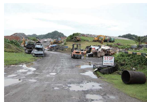
パラオ最終処分場建設 発注者: 東亜建設工業株式会社 概工費: 約13億1100万円 https://www.painuemb-japan-jc/jp/rpr_ja/b_000183.html
