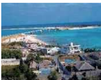
のほ 野甫大橋 ⑱
