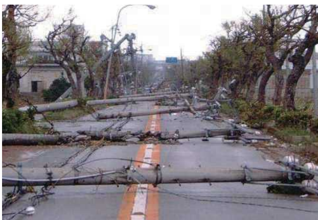
平良城辺線(宮古島市城辺) 平成15年台風14号で倒壊した電柱
