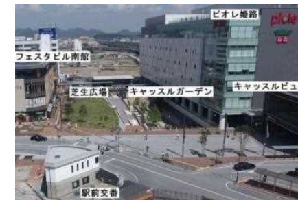
整備後の北駅前広場
