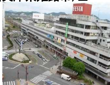
整備前の北駅前広場
