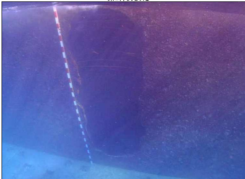
ケーソン壁が破損して、中詰め材が流出している状況
