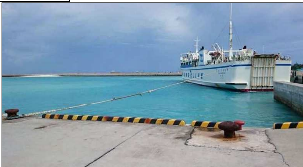
南風の時にロープを使用して旋回する様子
