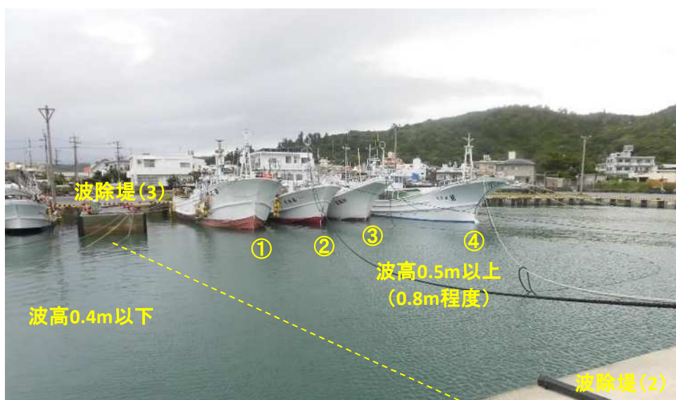
荒天時に静穏性が確保出来ない水域に係留する漁船 (平成28年7月撮影)
