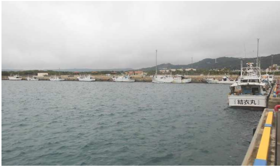
漁港の係留施設が不足し、近隣の港湾にて係留する漁船（平成28年6月撮影）
