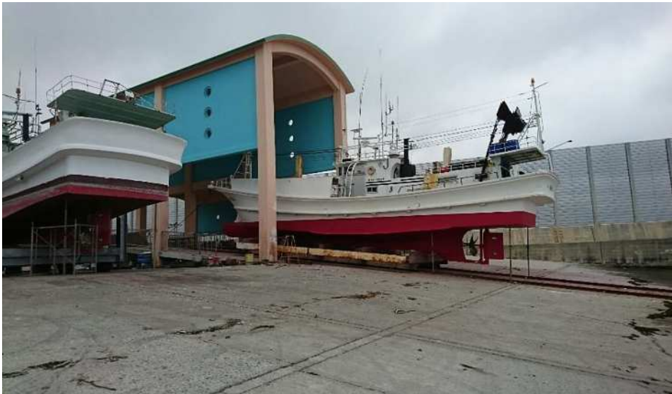
船揚場①（19トン漁船陸上係留状況）（令和元年6月撮影）
