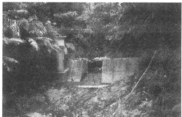
写真-4 量水堰の状況
