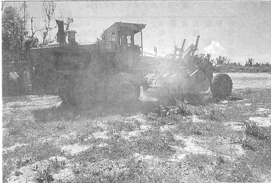
写真-4 破碎工（1回目）の状況
