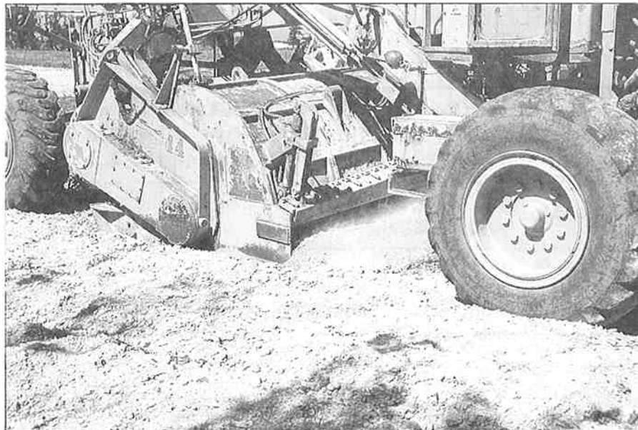
写真-5 破碎工（2回目）の状況
