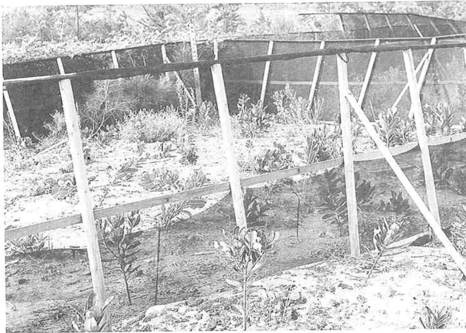
写真-2 台風により留め具部分から破損した防風ネット（石垣市白保海岸）
