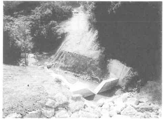
写真-2 量水堰（上流から下流を望む）
