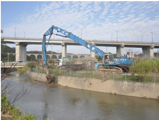
付図-20 伐株の掘削、浚渫（2013年）
