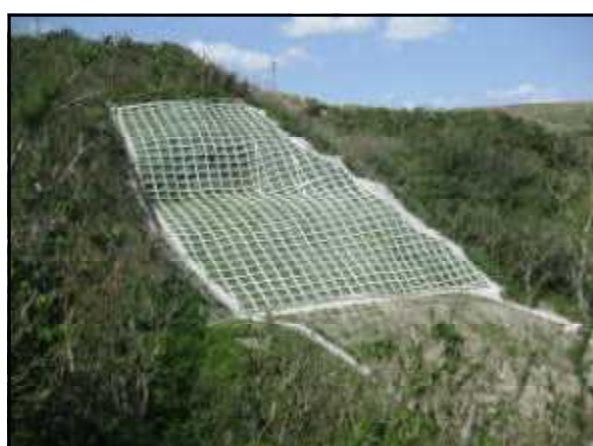
治山施設災害復旧事業(南城市)
