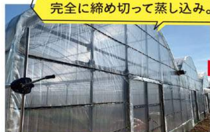
栽培終了後は圃場(施設)蒸し込み ※高温による配管パイプの曲がり等に注意
