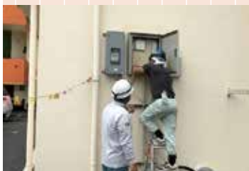
現場作業風景（にへでホーム）
