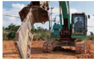
離島での試験圃場施工の様子
