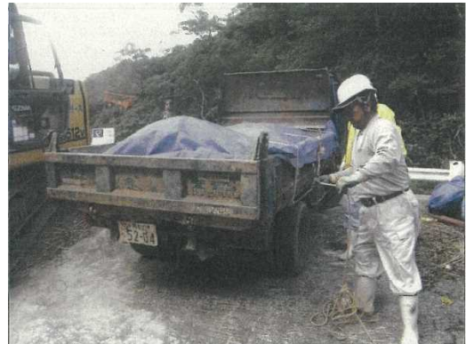
搬出の様子（二重のシートで覆う） (写真：沖縄県北部土木事務所提供)
