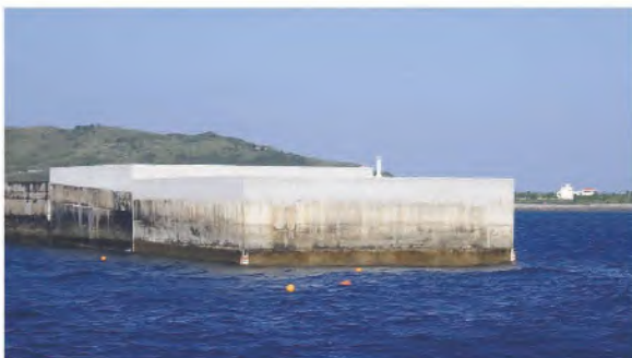
防波堤着手前
