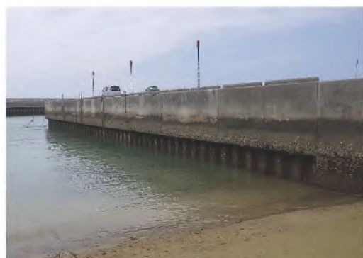
用地護岸着手前
