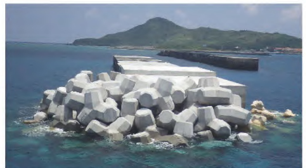
防波堤整備後
