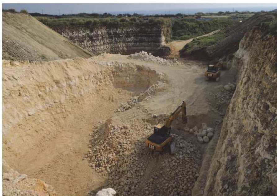
図 5. 3. 13 沖縄島南部の琉球石灰岩の採石場
